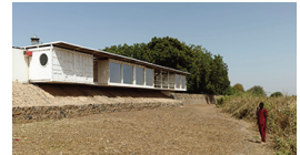
Studio TAMASSOCIATI, Centre d'urgences de de chirurgie cardiaque Salam au Soudan - Prix Aga Khan d'architecture 2013
