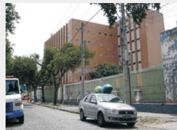
Novembro/2008 - Edifício Otis já demolido (Telemar ao fundo).
